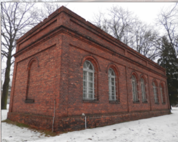
Budynek przed remontem...
