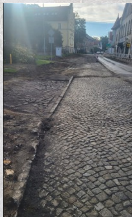
Bruk, który wyłonił się spod warstwy asfaltu, podczas przebudowy drogi 921 w centrum Pilchowic.
