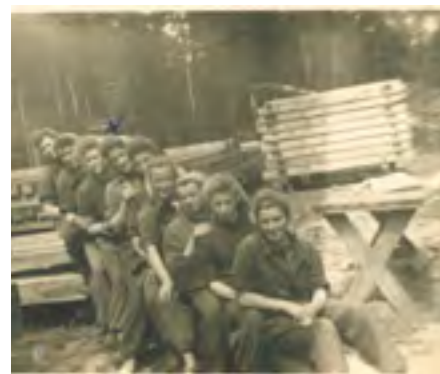
Maria Duda podczas pracy przy budowie torów w 1950r.
