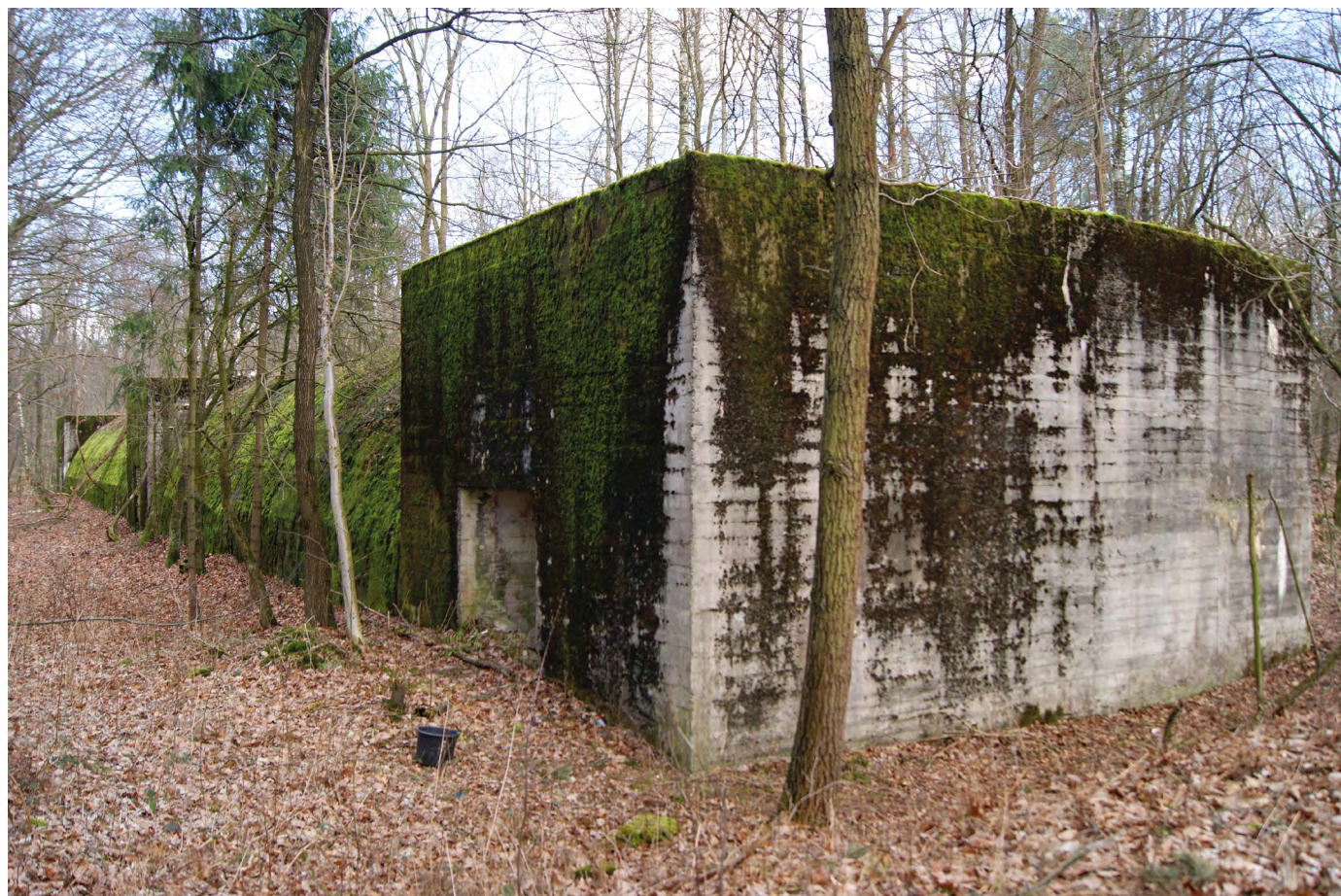
Schron ochrony powietrznej typu Slatzitter
