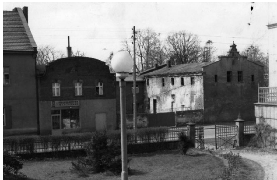
Widok budynku, w którym mieścił się sklep Wilhelma Kaczmarczyka, zdjęcie zrobione od strony szpitala w latach 80. XX w.
