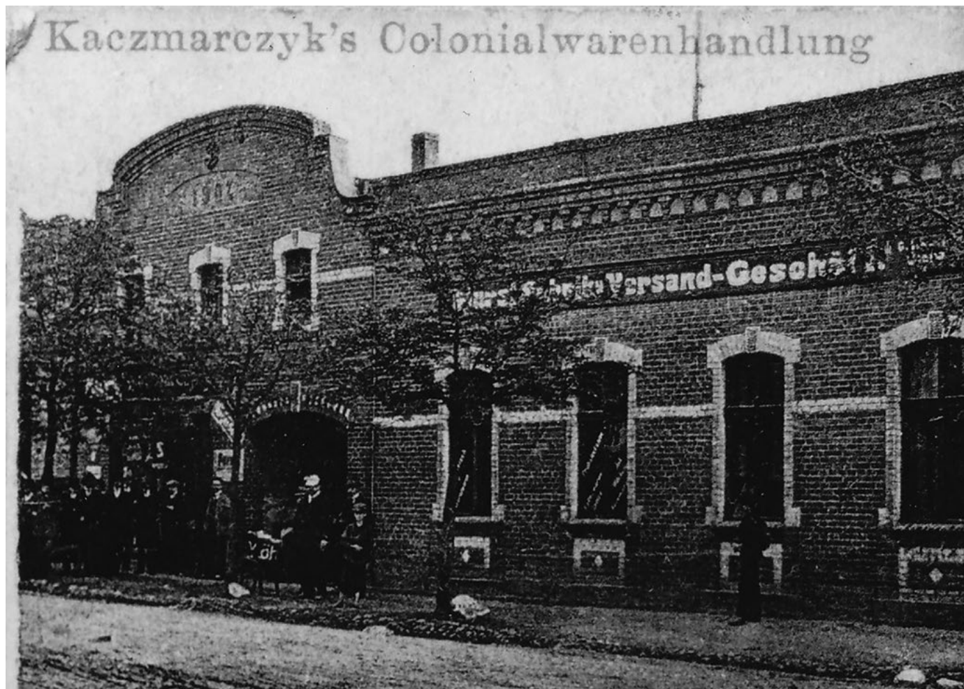
Sklep kolonialny Kaczmarczyka przy ulicy Dworcowej na pilchowskiej widokówce. Na froncie domu data 1907. Fragment budynku widoczny na pierwszym planie już nie istnieje. Dalszy został mocno przebudowany
